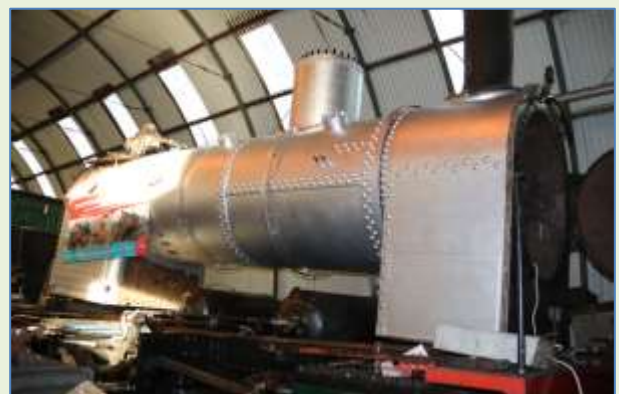
Volledige restauratie stoomketel
