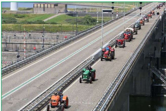
Met de trekker over de sluisen.
