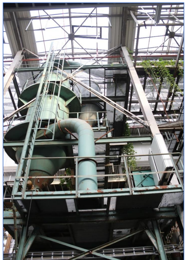
Ook de installaties om zakken af te vullen zijn nog aanwezig.
