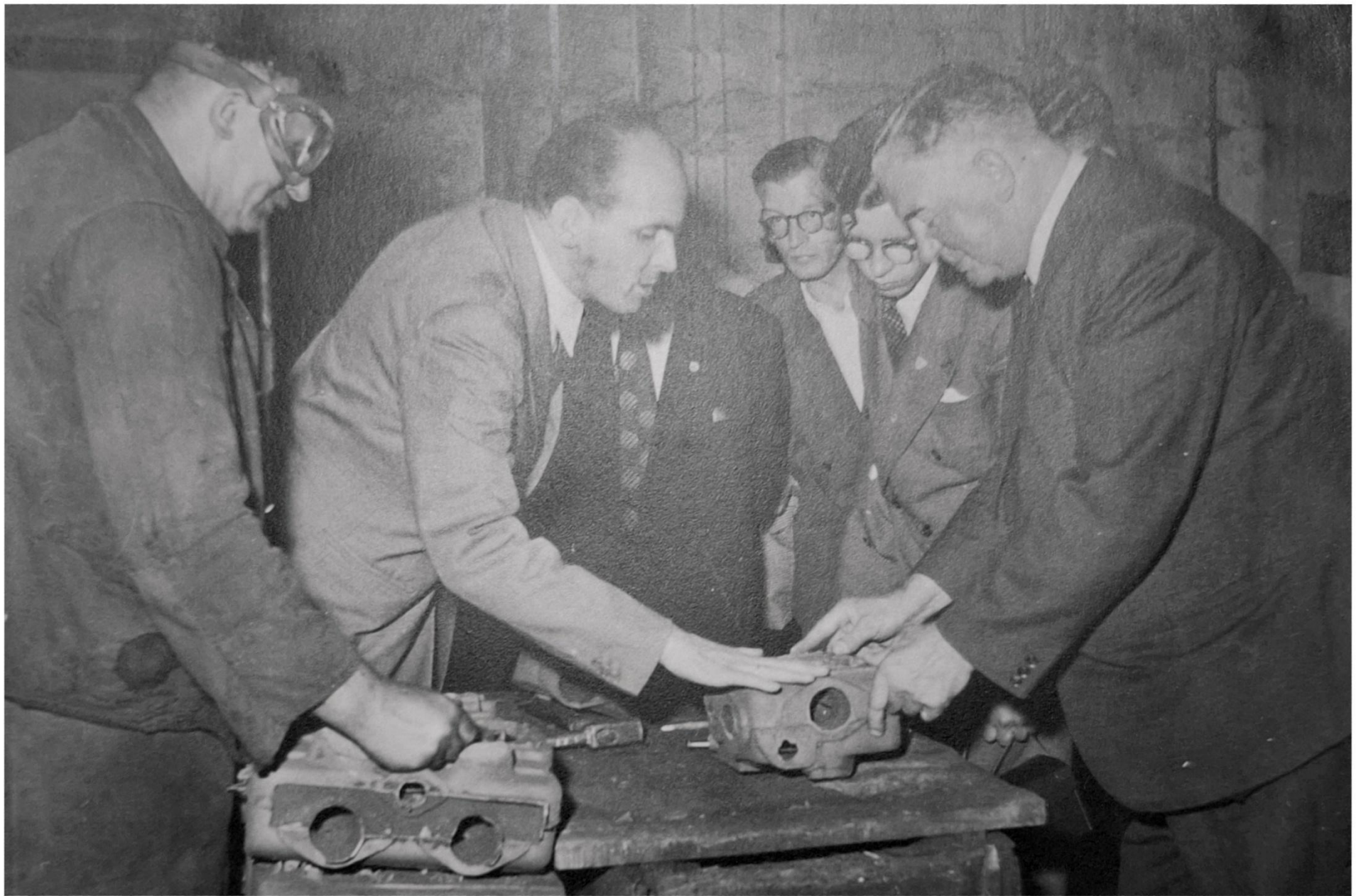
Zandstraal gereinigde cilinderblokken in de schoonmakerei
